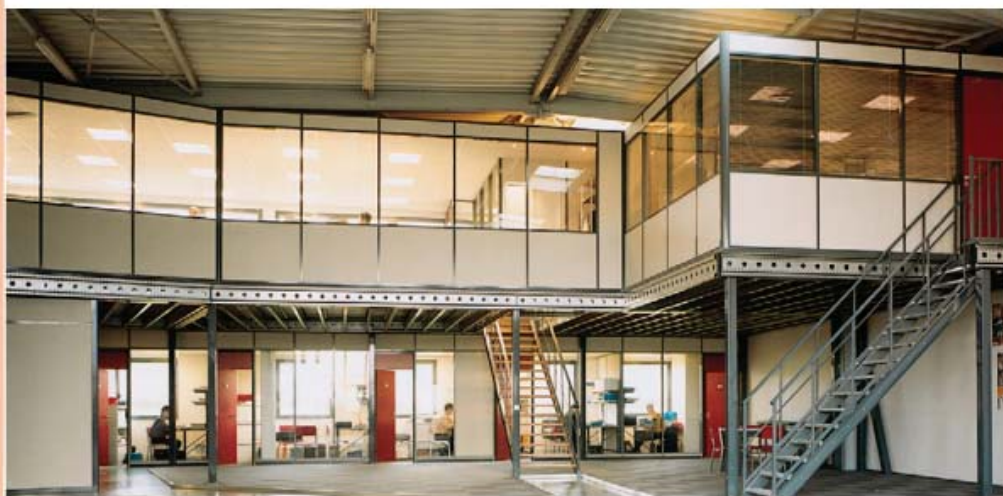
Principe de plate-formes à échelles pour monter d'un niveau et doubler les surfaces.
