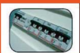
Disjoncteur différentiel 30 mA 32A
